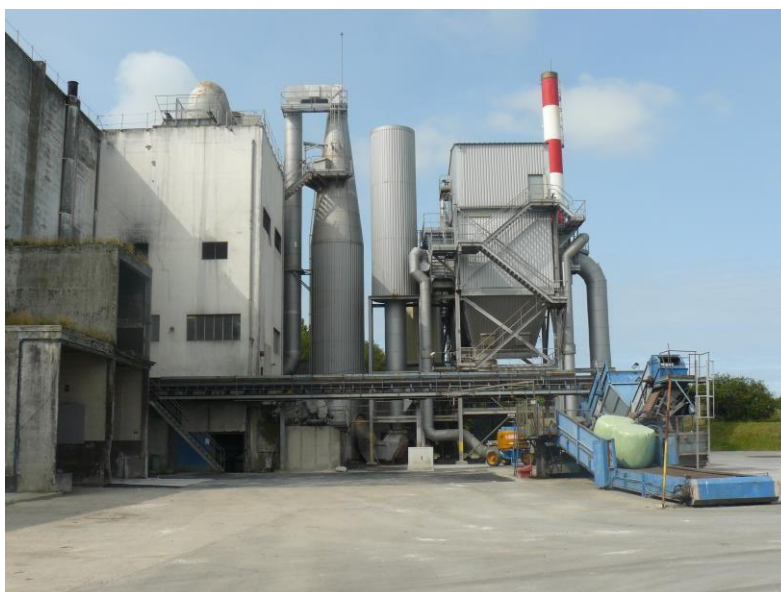
Usine d'incinération à Plouharnel
