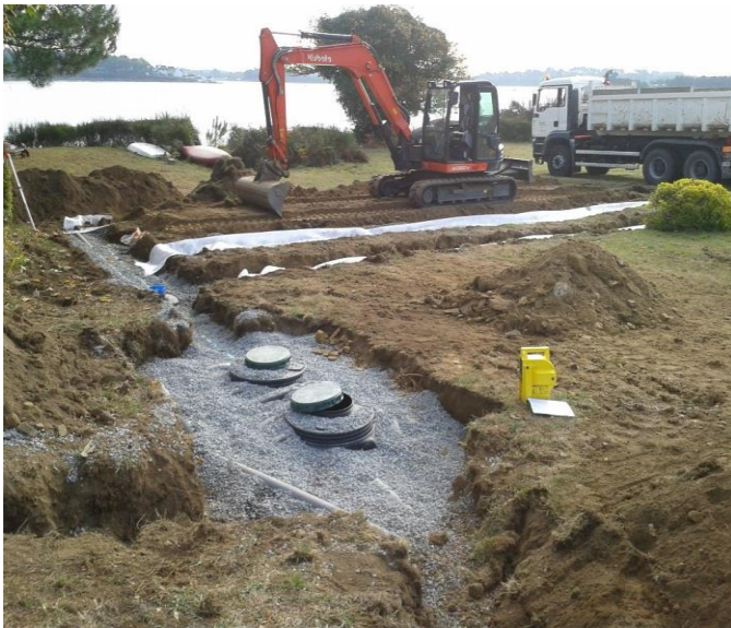
Chantier au moment des travaux (Plouhinec)
