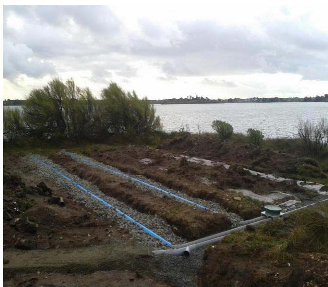
Chantier au moment des travaux (Sainte-Hélène)
