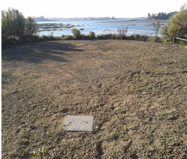
Chantier après les travaux (Sainte-Hélène)
