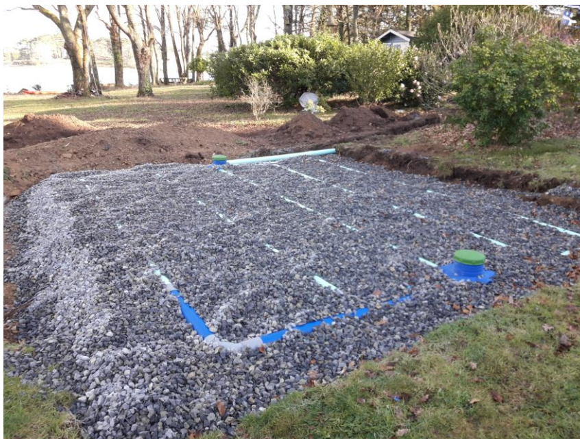
Installation d'un filtre à sable non drainé (Sainte-Hélène)
