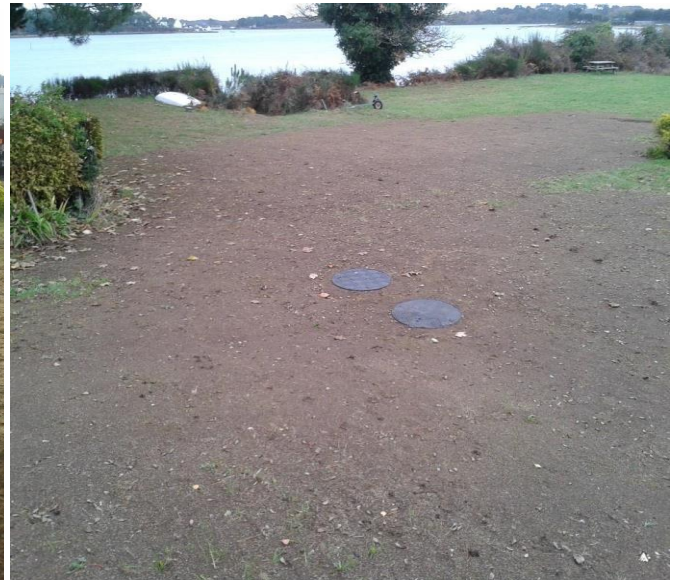
Chantier après les travaux (Plouhinec)
