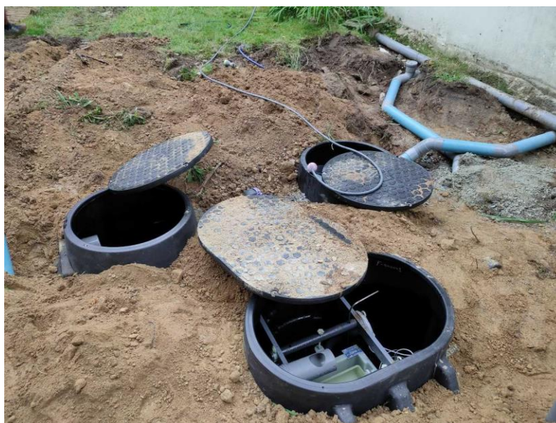
Figure 2 : Filtre compacte ECOFLO 6 EH
