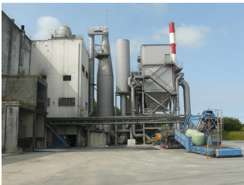
Usine d'incinération à Plouharnel
